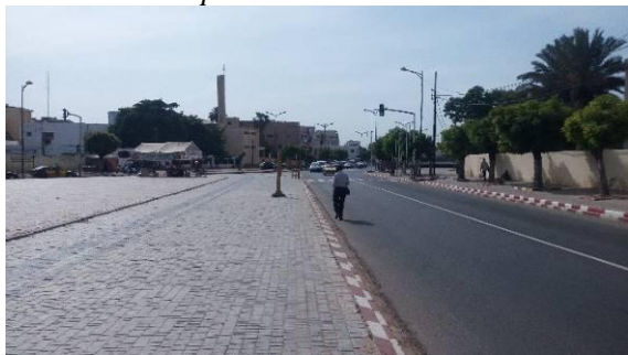
Photo 9 : Voie pavée en début de section
