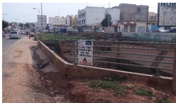
Photo 30 : Station EP au niveau du pont
