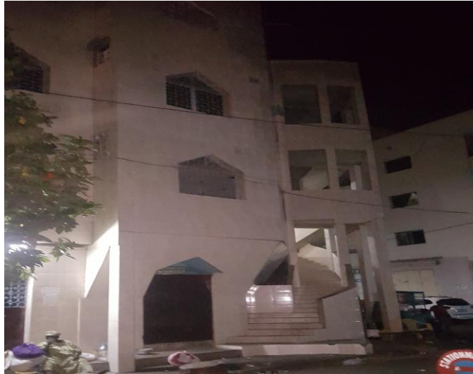
Vue d'un bâtiment impacté à l'entrée de la rue Escarfait
