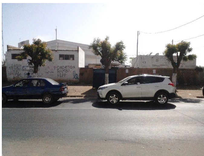
Photo 11 : 2 magasins de l'I A impactés
